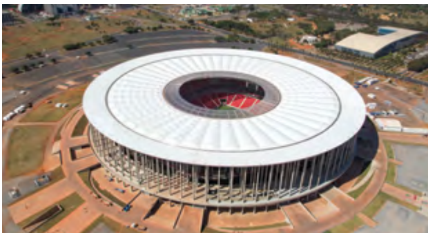
Estádio Nacional, Brasília: TROX Raumlufttechnik in allen neu errichteten WM-Stadien in Brasilien
