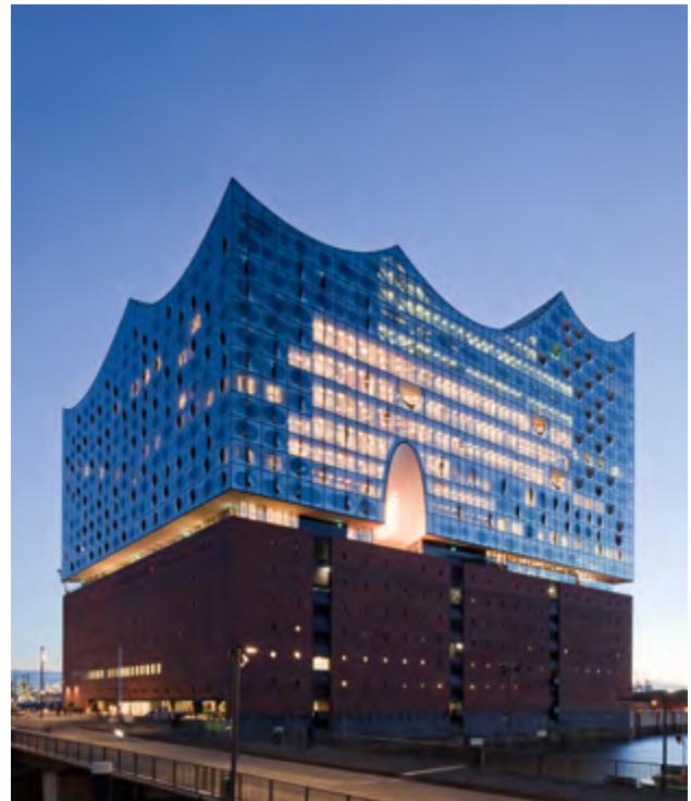
Elbphilharmonie Hamburg: TROX Raumlufttechnik in allen Konzertsälen
