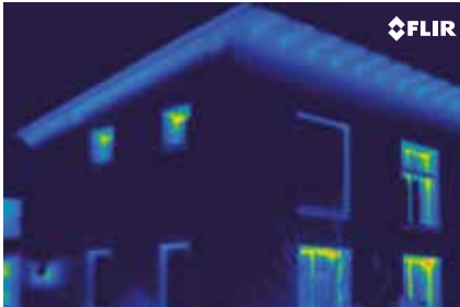
Das Wärmebild zeigt die Dämmungsqualität eines Niedrigenergiehauses.
