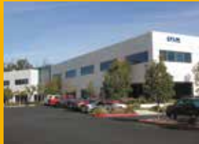
FLIR Santa Barbara, USA
