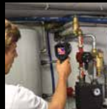
Inspektion von Heizsystemen
