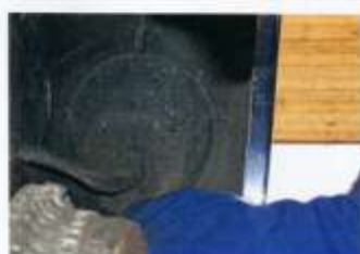
Die größte Rostfalle vorne sind die Scheinwerfertöpfe, die oft durchrosten.
