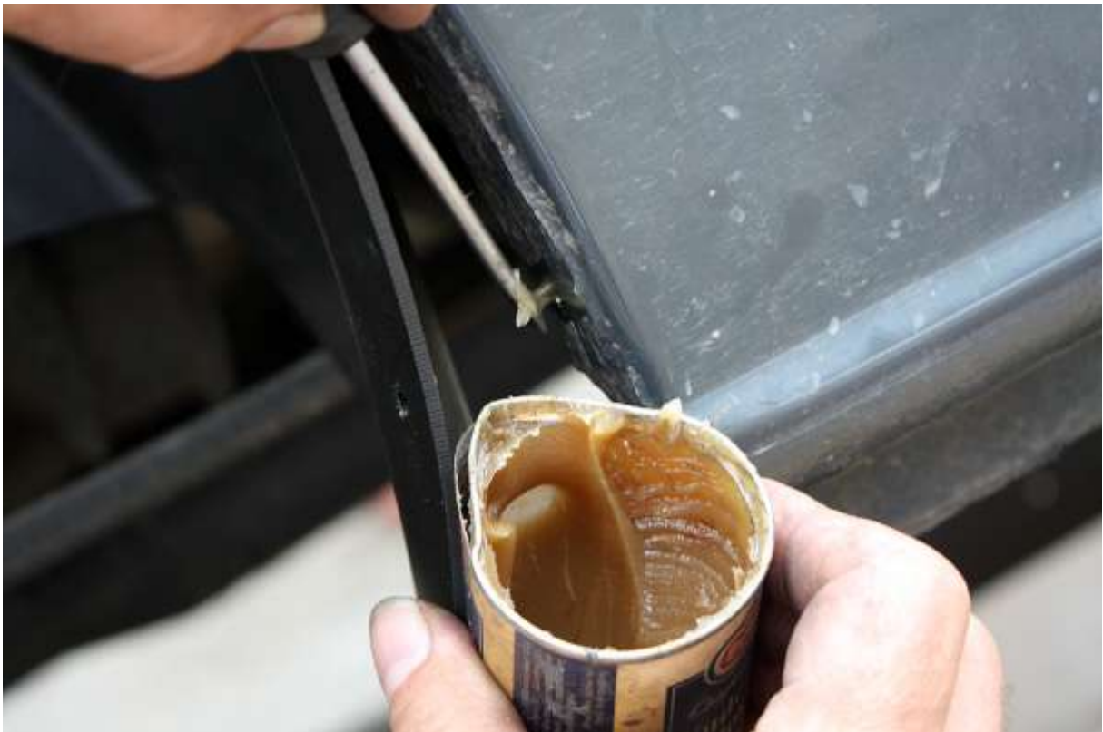
Einstreichen des Korrosionsschutzfettes in die Bohrlöcher im Blech
