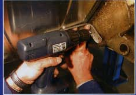
Wermutstropfen: Ein kleines Loch muss in die tragende Längsstrebe gebohrt werden
