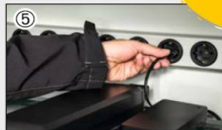
Steckdosenleiste mit Metallgehäuse und Schutzkontakt-Steckdosen
