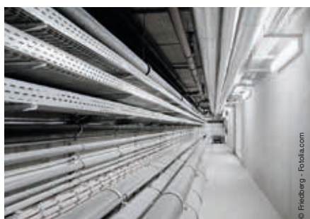
Befestigung von Kabelschächten
